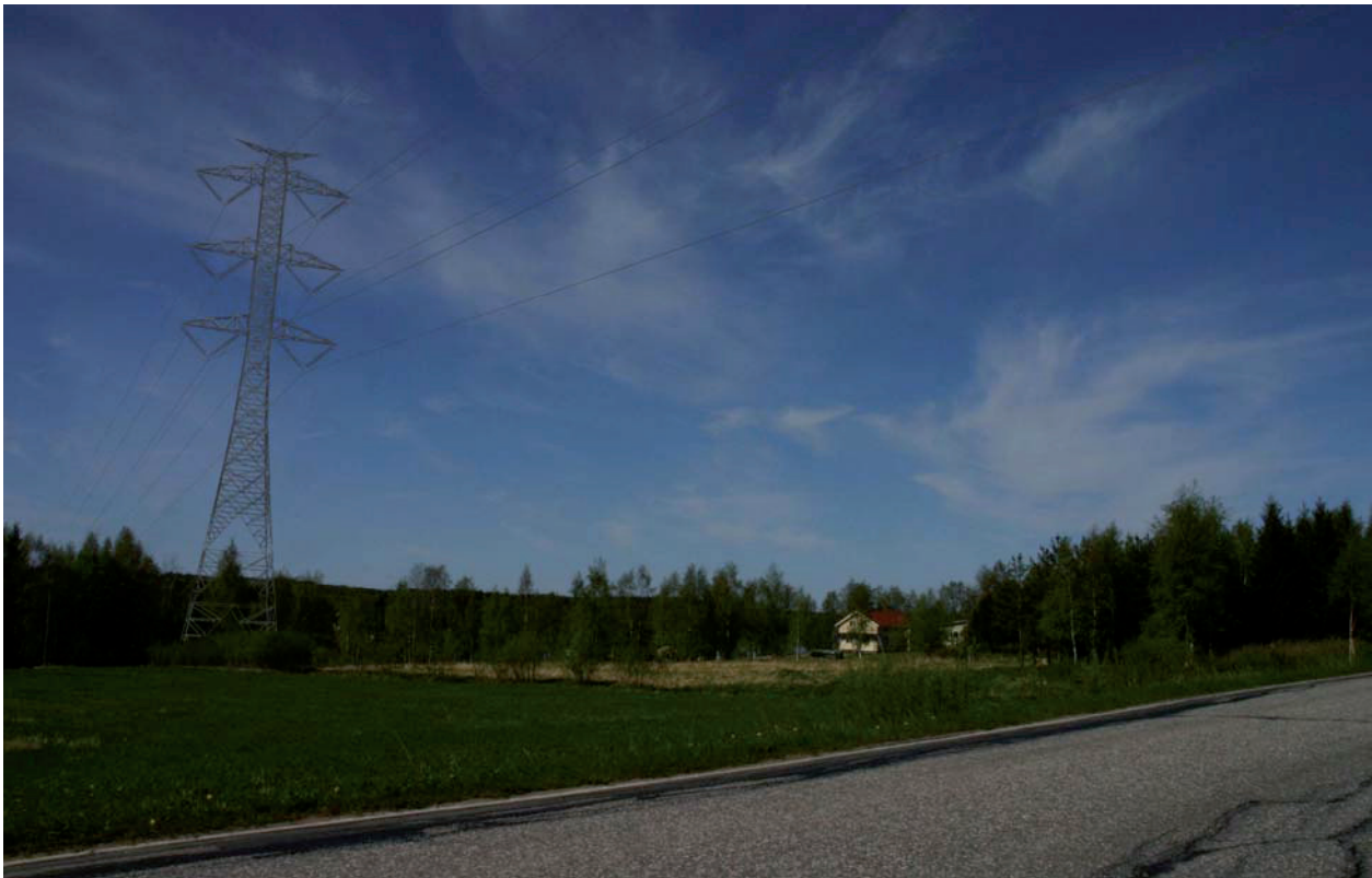
V-9 Voimajohto, RVE1, 2, ja 3, Kemijoen ylitys 2 x 400 kV yhteispylväs –ratkaisu
