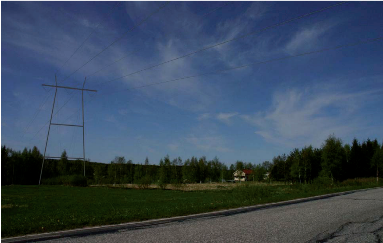
V-9 Voimajohto, RVE1, 2, ja 3, Kemijoen ylitys 2 x 400 kV yhteispylväs –ratkaisu
