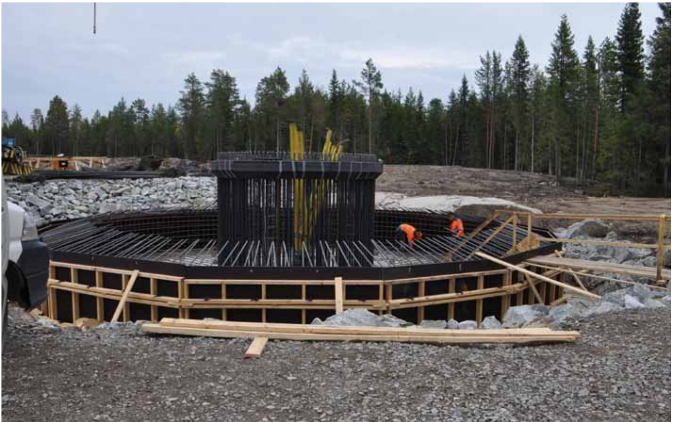
Kuva 5-11. Tuulivoimalan perustusten rakentamista (Kuva: Leila Väyrynen / FCG).
