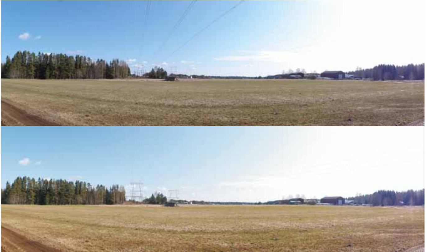
Kuva 21-5. Yläkuvasa nykyiset voimajohdot Jylkän peltoaukealla. Alakuvasa havainnekuva tulevasta tilanteesta Jylkän peltoaukealla. Kuvassa tuleva 400 kV voimajohto sekä yhteispylväiseen tulevat tuulivoimapuistojen 110 kV voimajohto ja 220 kV korvaavan 110 kV voimajohdot.
