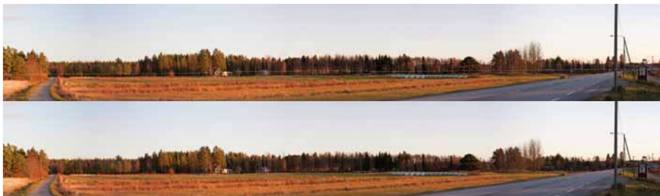
Kuva 21-3. Näkymä Unsitalon kohdalta valtatieltä 8 Mäkekankaan tuulipuiston eteläpuolelta kohti Tohkojan ja Jokelan tuulipuistoja. Yläkuvassa WindPro- luonnos voimaloiden näkyvyydestä ja alakuvassa valokuvaversiona samasta kuvasta kapeammalta sektorilta. Voimaloiden lavat ja tornin yläosa näkyvät paikoin puuston latruston yläpuolella. Kasvillisuus katkaisee näkymät voimakkaasti. Etäisyys lähimpiin voimaloihin noin 3,4 km.
