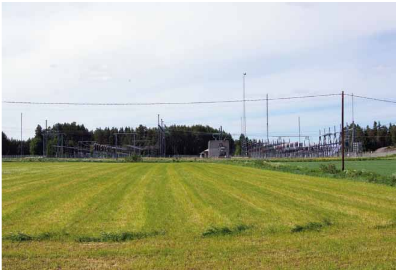
Kuva 5-7. Kalajoen 110 kV sähköasema sijaitsee Jylkässä. (Kuva © npd / K. Joensuu)
