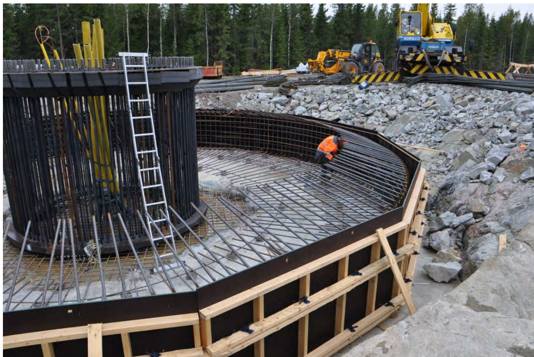
Kuva 5-5. Tuulivoimalan perustusten rakentamista. (Kuva: Leila Väyrynen, FCG)
