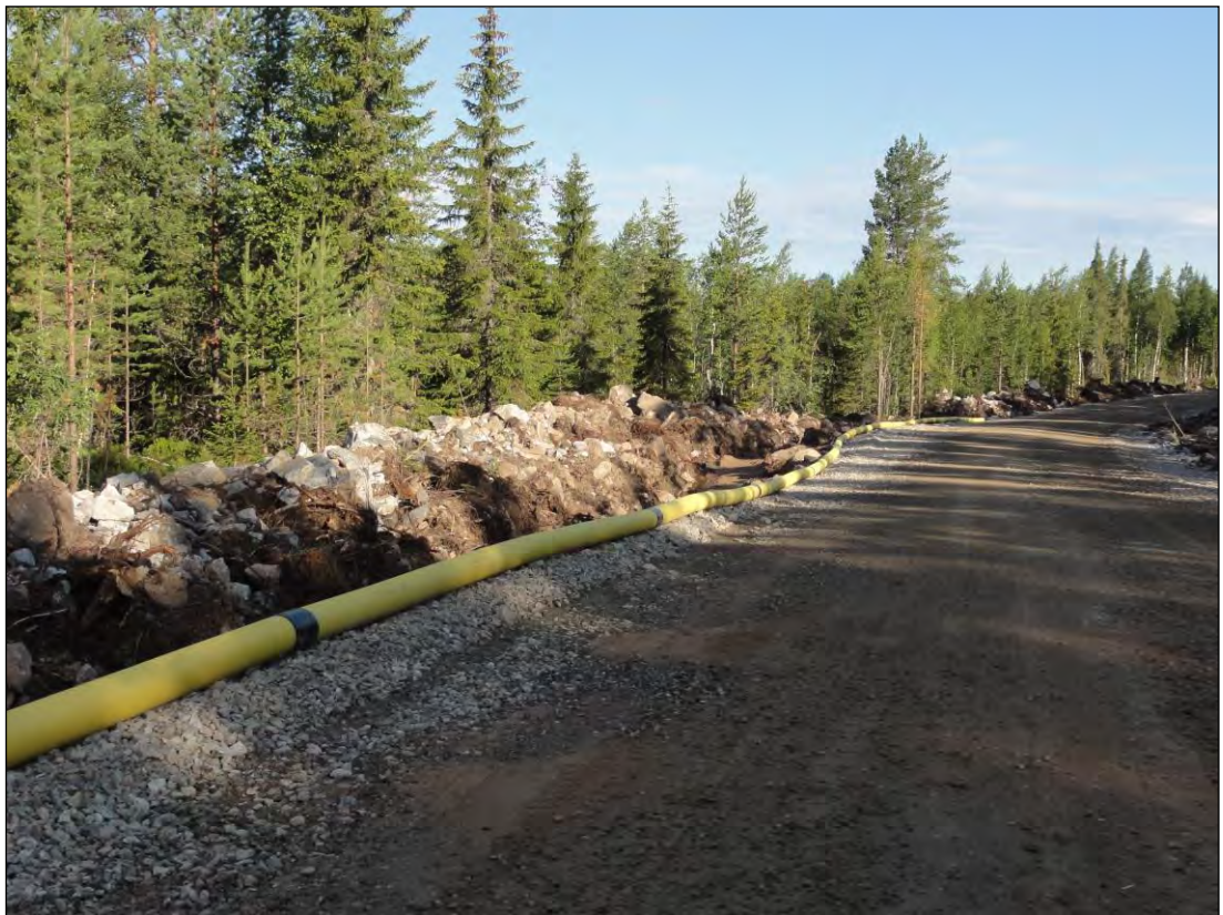
Kuva 5.3. Esimerkki tuulivoimapuiston rakennus- ja huoltotiestä. Teitä käytetään muun muassa betonin ja soran sekä voimaloiden komponenttien kuljetuksiin. Tuulivoimapuiston käyttövaiheessa teitä käytetään mm. vuosittaisissa huolloissa. Maakaapeli sijoitetaan ojakaivantoon tien reuna-alueelle. (Kuva: Ville Suorsa / FCG).
