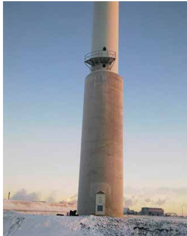
Kuva 10. Hybriditorni, Tornio (Ramboll Finland Oy).
