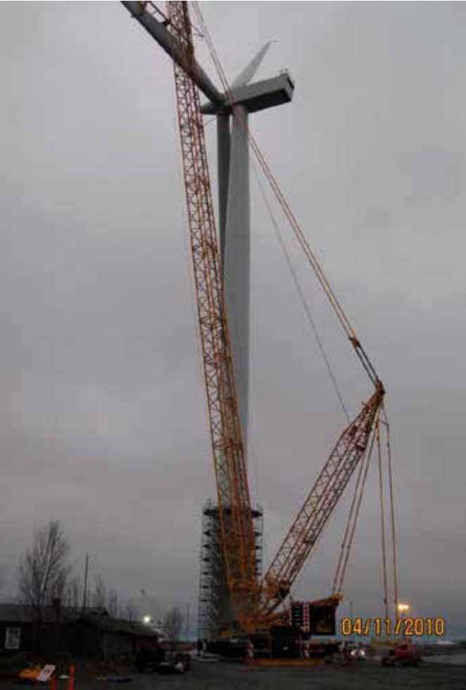
Kuva 16. Tuulivoimalan pystytys tela-alustaisella nosturilla (Liebherr).
