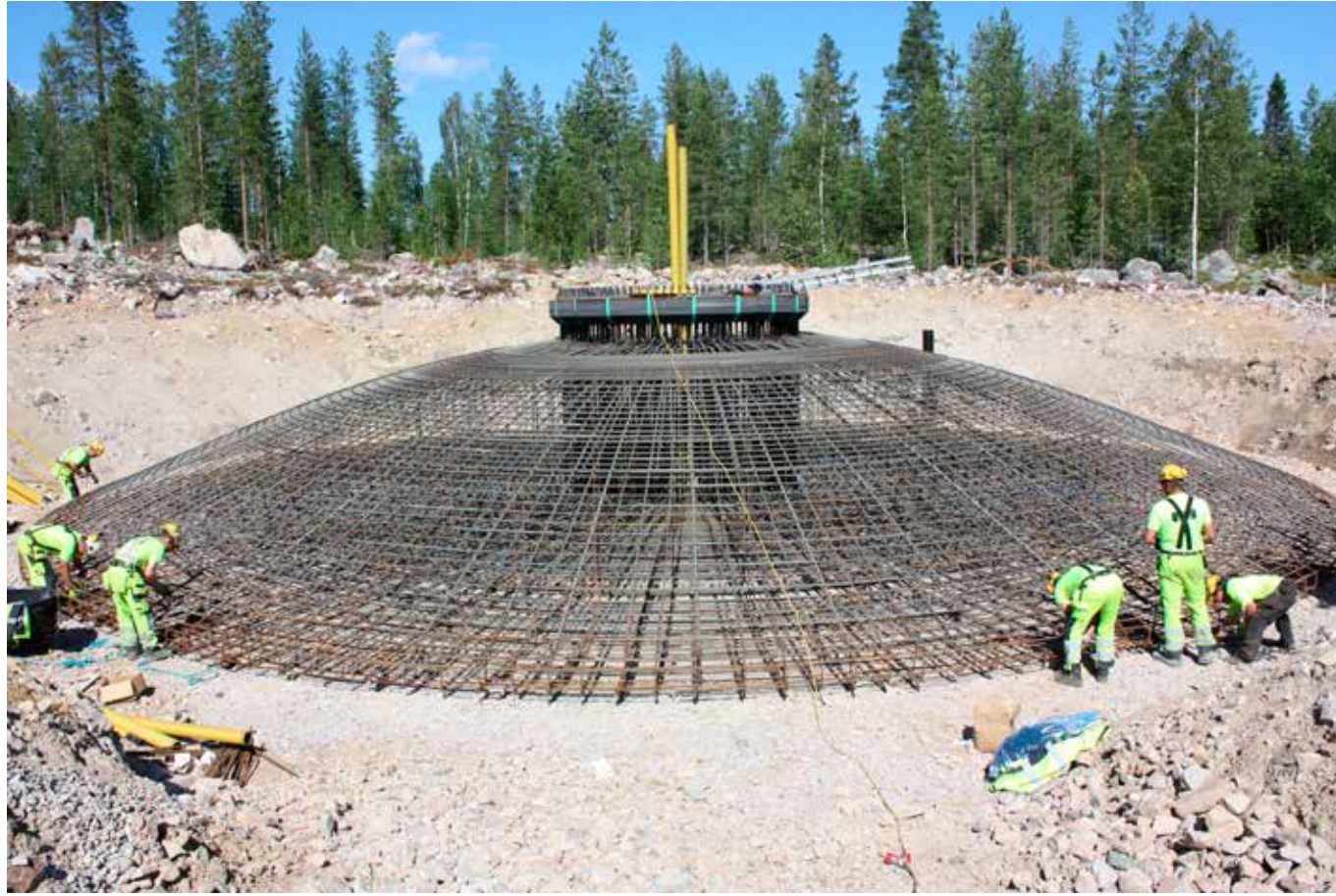
Kuva 9. Maanvarainen teräsbetoniperustus randoitettuna ennen betonivalua, Tervola (Ramboll Finland Oy 2013).
