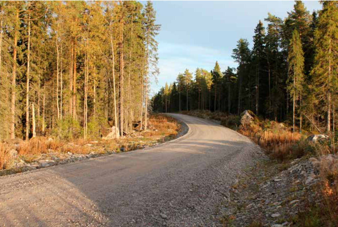
Kuva 13. Tuulivoimalan huoltotie – Öjen, Vaasa (Ramboll Finland Oy).
