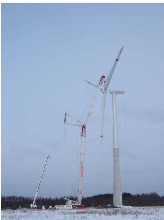
Kuva 5-8. Kuva tuulivoimalan pystytyksestä.
