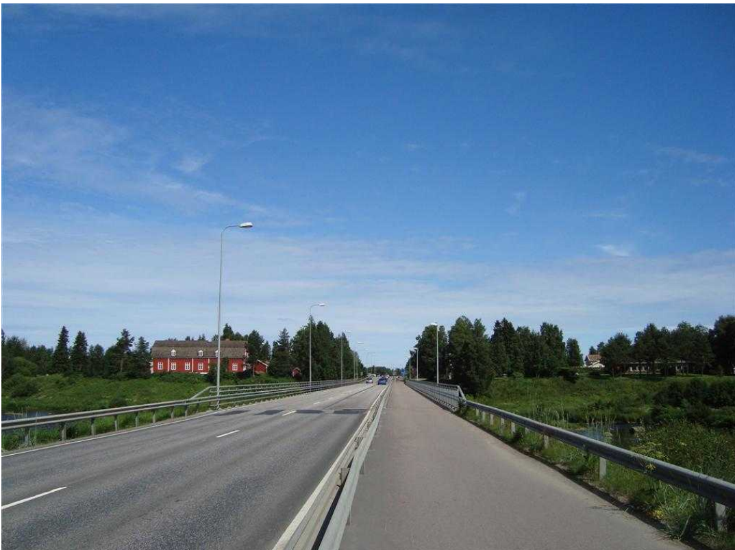
Kuva 6-16. Näkymä Kalajoen ylittävältä sillalta, vasemmalla pappila.
