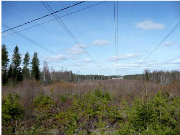
Kuva 15 Rajaperän kohdalla koilliseen.
