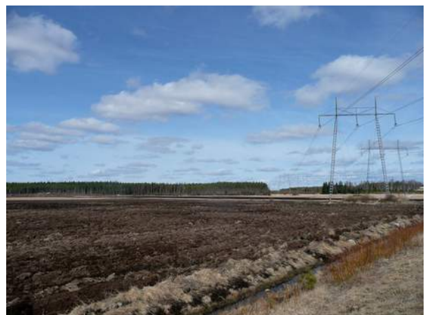
Kuva 14 Patakorven kohdalla koilliseen.
